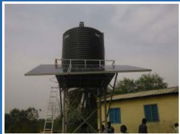
Capacity : 100 KWp Year : 2014
