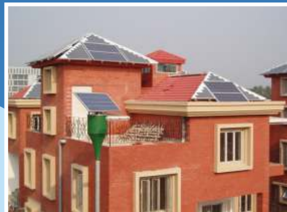
Capacity : - KWp Year : 2014
